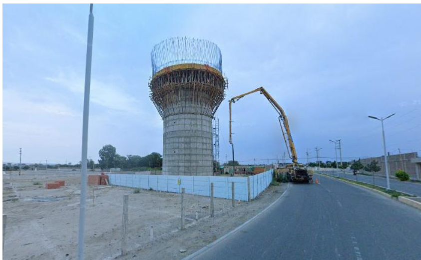
Desarrollo de nueva infraestructura de agua potable.
