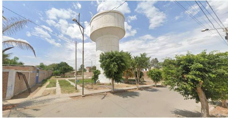
Imagen 29.- Infraestructura para dotación de servicios básicos.
