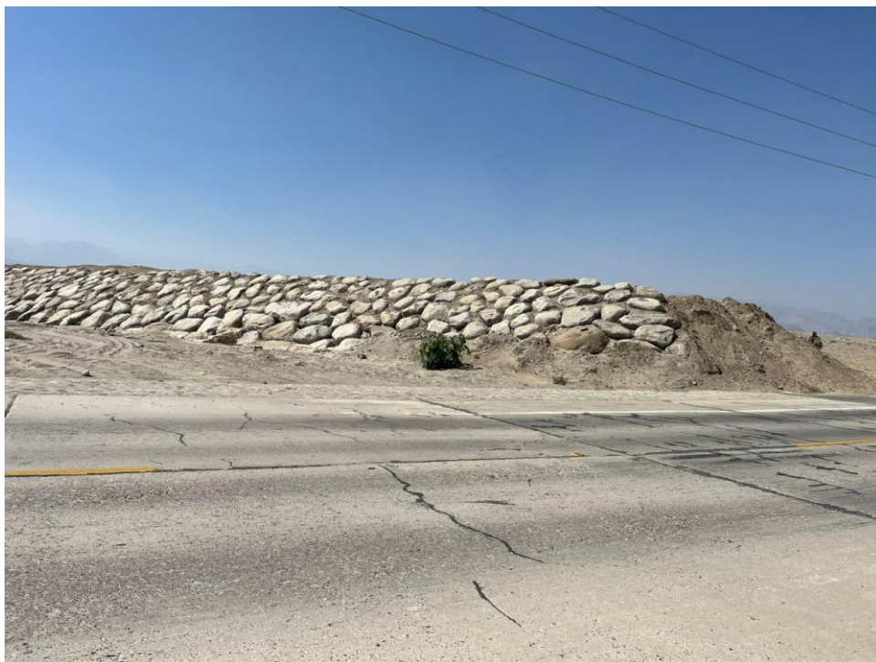
IMAGEN 46: OBRAS DE MITIGACIÓN DE RIESGO DE DESASTRE FUENTE: Elaboración Propia. 2025.
