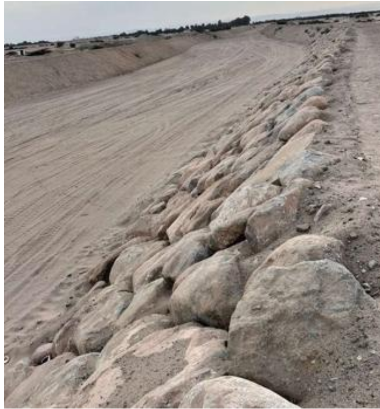
IMAGEN 48: OBRAS DE MITIGACIÓN DE RIESGO DE DESASTRE FUENTE: Elaboración propia. 2025.
