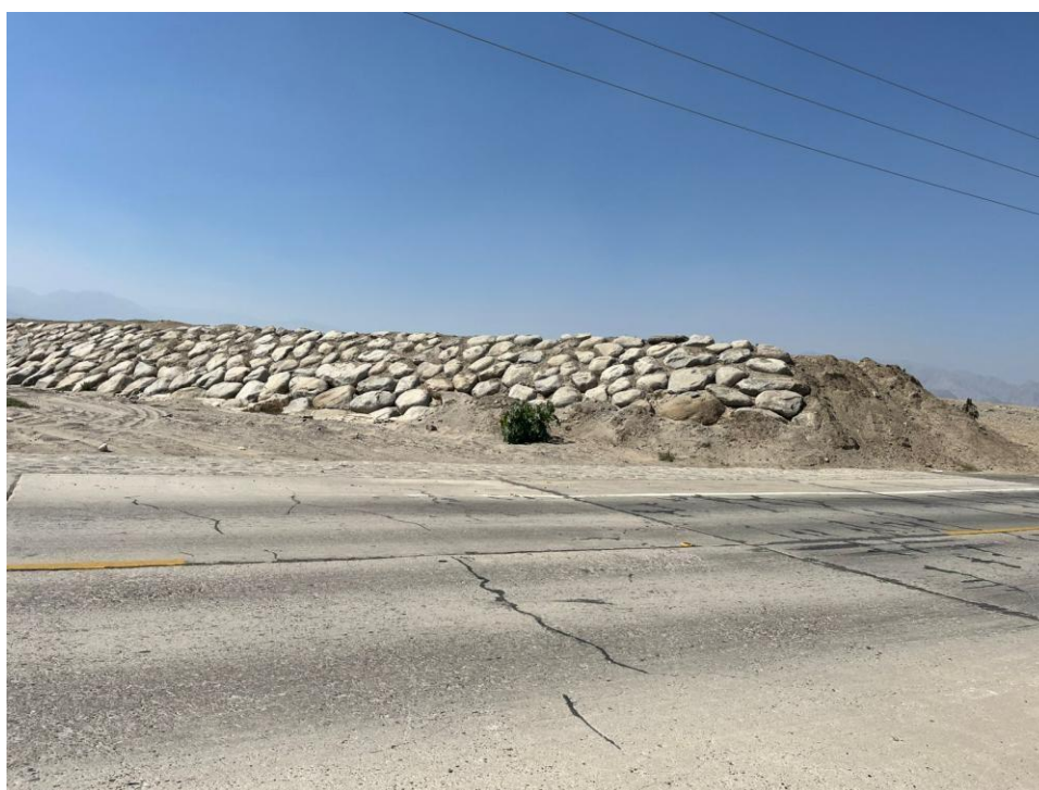
IMAGEN 06: OBRAS DE MITIGACIÓN DE RIESGO DE DESASTRE FUENTE: Elaboración Propia. 2025.
