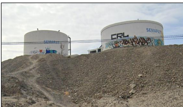
Infraestructura para prestación de servicios de saneamiento.
