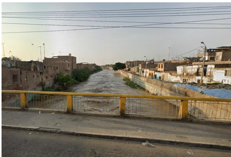
Rio Ica, en el sector central de la ciudad, donde el cauce se ve angostado por las edificaciones existentes.
