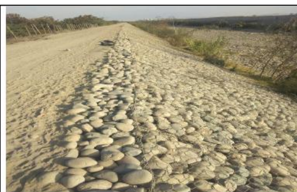
FOTO N° 03: GABIONES DE PIEDRA UBICADAS EN MARGEN DEL RIO ICA
