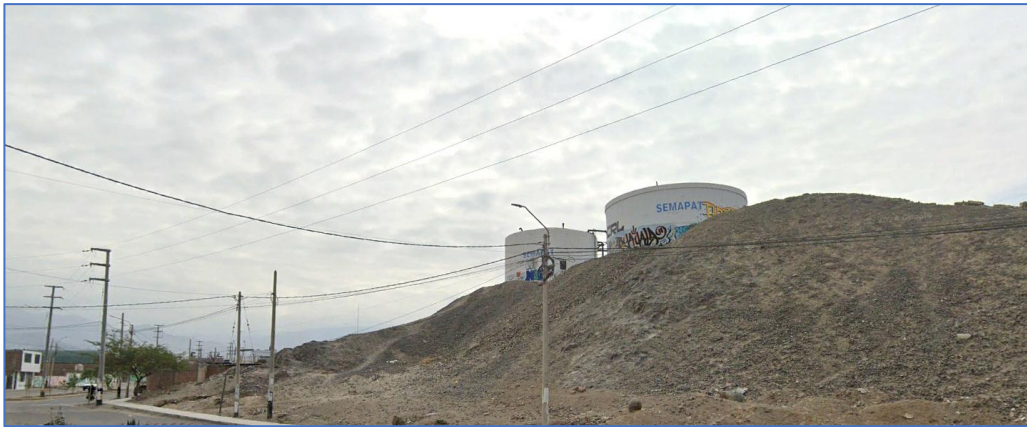
Imagen N° 33. Imagen de los Reservorios Apoyados de SEMAPAT.
