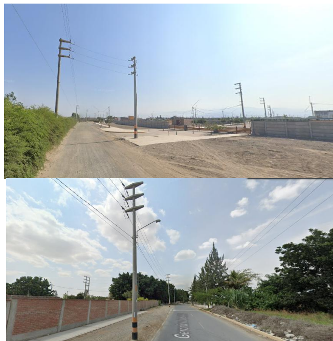
Imagen 26- Redes eléctricas de media tensión en las vías circundantes al predio.
