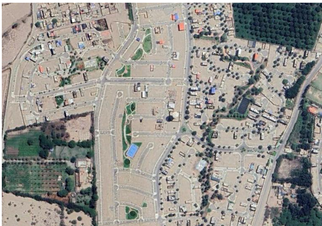
Imagen 57.- Áreas Recreacionales ubicadas en las nuevas habilitaciones del Sector El Haras.
