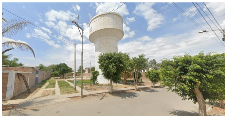
Imagen 29.- Infraestructura para dotación de servicios básicos.
