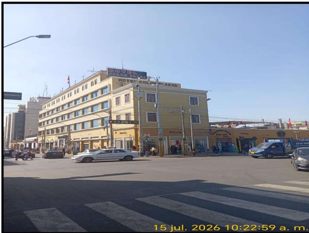
Foto. Calle Callao cruce Av. Municipalidad
