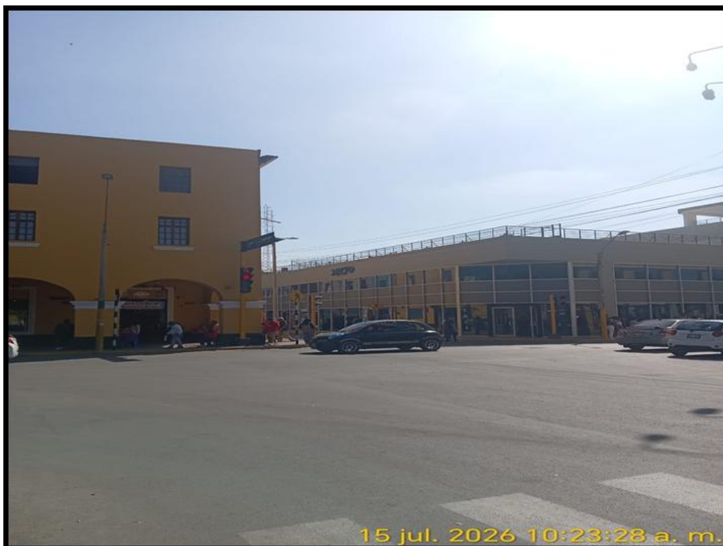
Foto. Calle Callao cruce Av. Municipalidad
