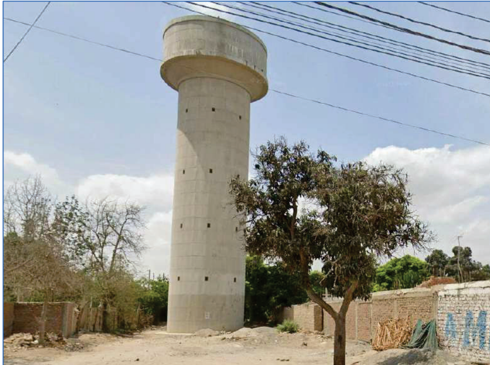
Imagen N° 32. Imagen de Reservorio Elevado en el Sector de Collazos.
