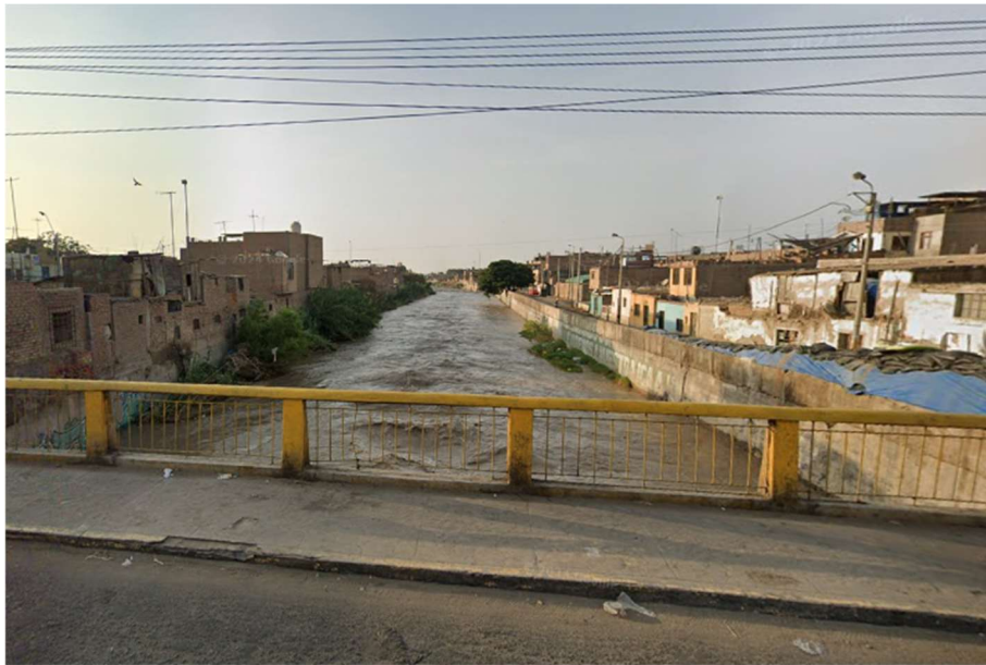
Rio Ica, en el sector central de la ciudad, donde el cauce se ve angostado por las edificaciones existentes.
