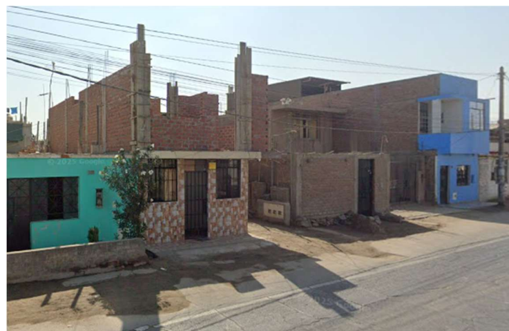
Sectores urbanos aldeaños, empleo de sistemas estructurales de albañilería confinada sin supervisión.
