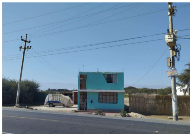
Redes Eléctricas existentes. (Frontis del predio).
