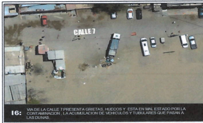
Imagen N°37: Problemática identificada en la calle 7.
