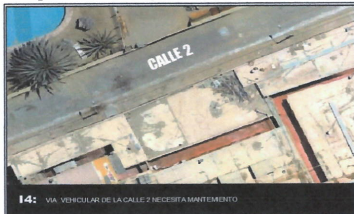
Imagen N°35: Problemática identificada en la calle 2.
