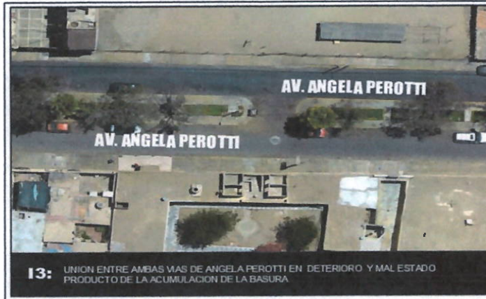
Imagen N°34: Problemática identificada de la av. Angela Perotti.
